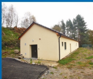
ČOV Bukovany – 700 EO
